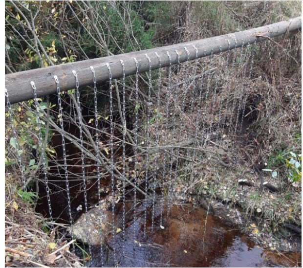
Kuva 7 (vas.) Vesistöaitaa voidaan käyttää maalle pystytetyn petoaidan jatkeena. Kuva: Mari Tikkinen. Kuva 8 (oik.) Roikkuvien ketjujen suojausta petoaidan ojanmyllyssä. Kuva: Jaakko Alalantela.
