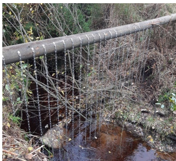
Bild 3 (vä.) En inhägnad för vattendrag som fortsättning på ett rovdjursstängsel på land. Bild: Mari Tikkunen. Bild 4 (hö.) Kättingar som skydd där rovdjursstängslet korsar ett dike. Bild: Jaakko Alalantela.
