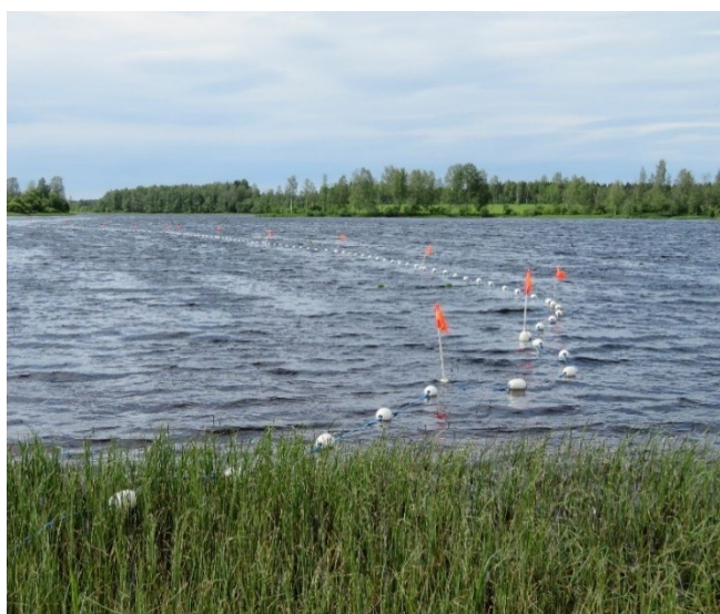
Bild 3 (vä.) En inhägnad för vattendrag som fortsättning på ett rovdjursstängsel på land. Bild: Mari Tikkunen. Bild 4 (hö.) Kättingar som skydd där rovdjursstängslet korsar ett dike. Bild: Jaakko Alalantela.
